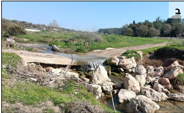
איור 1: א. שינוי רוחב ועומק הערוץ במעביר אירי. ב. הצטברות סדימנטים במעלה למעביר והיווצרות מדרגה במורדו. תמונות מנחל ציפורי.
