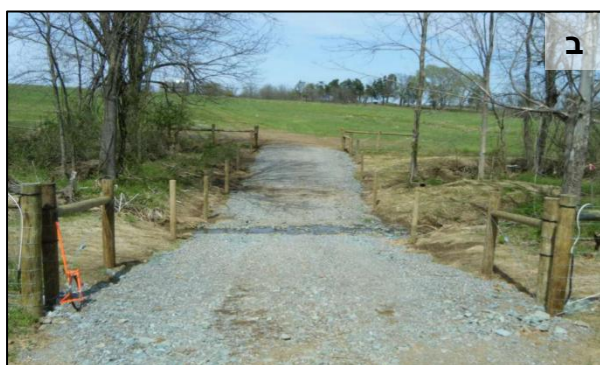
איור 12: א. מעביר אירי סלול משופר עם ערוץ לזרימות בסיס (Key, 2014), ב. מעביר אירי לא סלול מחוזק (Coleman, 2018).
