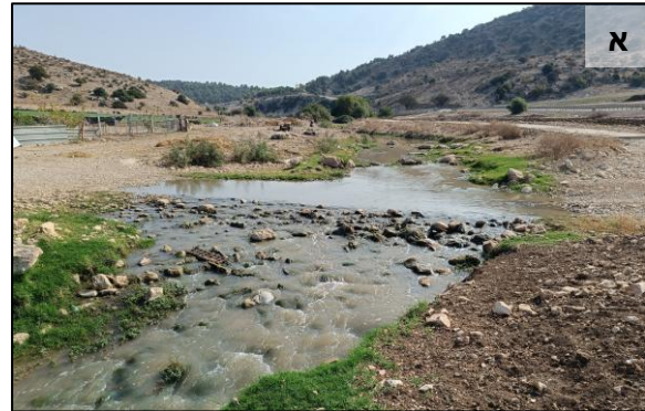
איור 1: א. שינוי רוחב ועומק הערוץ במעביר אירי. ב. הצטברות סדימנטים במעלה למעביר והיווצרות מדרגה במורדו. תמונות מנחל ציפורי.
